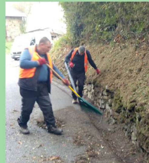
Curage nettoyage des voiries
