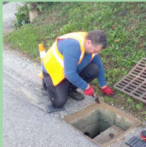
Nettoyage des bouches d'égout
