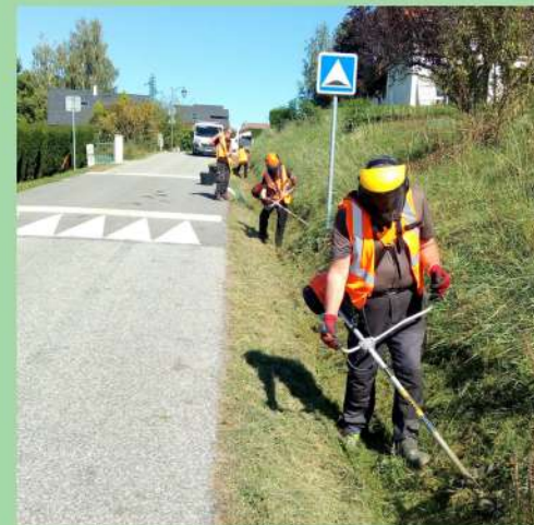
Curage nettoyage de cunettes et caniveaux
